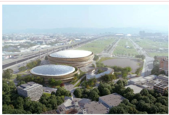
台中巨蛋2024年開工 預計2030年完工
